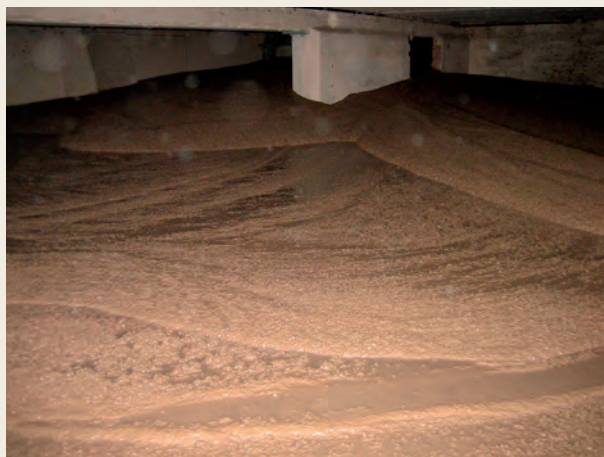
Stollen - Keller - Hohlraumverfüllung
